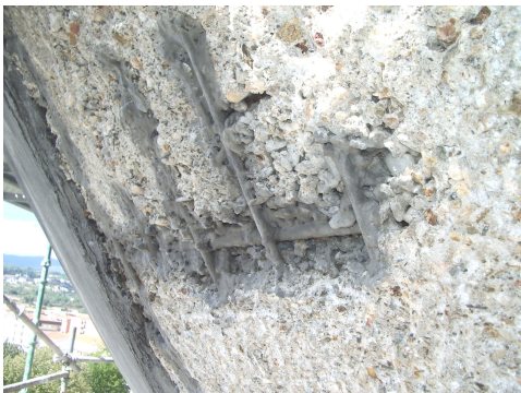
Figura 16 – Protecção das armaduras e aplicação de argamassa de reparação
