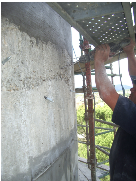
Figura 14 – Furação para colocação de injectores;
