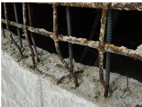
Figura 8 – Completação com varões adicionais;
