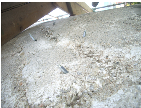
Figura 15 – Distribuição dos injectores ao longo duma fissura.
