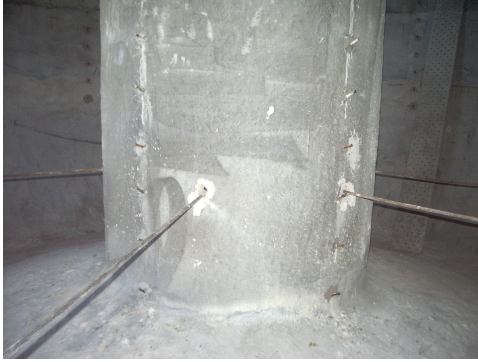
Figura 5 – Tirantes atravessando o fuste do depósito;
