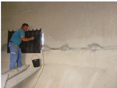
Figura 9 – Colocação de cofragem;
