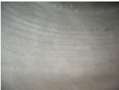
Figura 13 – Aspecto do betão, após projecção
