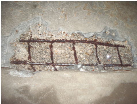
Figura 2 – Viga de coroamento, armaduras visíveis pelo interior;
